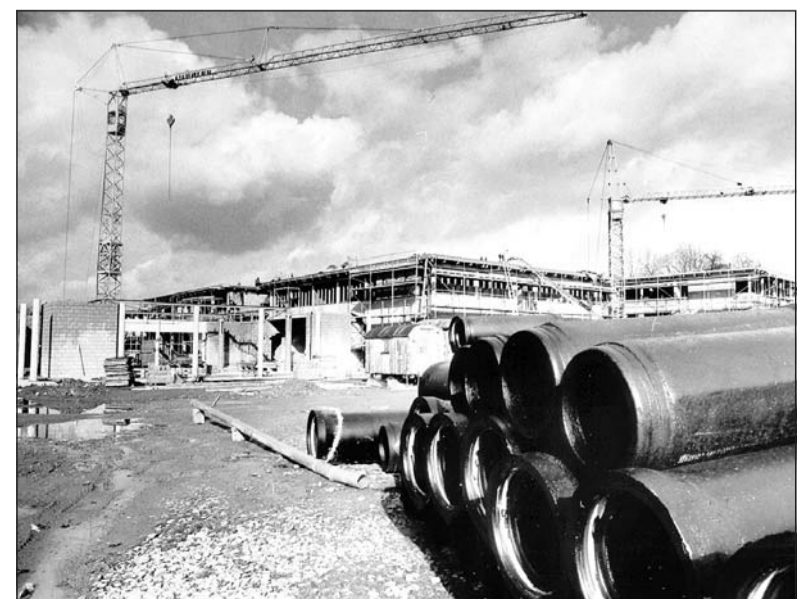
Mitte der 1980er Jahre hatte sich das Areal im Friedenstal in eine riesige Baustelle verwandelt, als die Gesamtschule entstand. 1991 wurde die dort zuvor bestehende Hauptschule aufgelöst.
